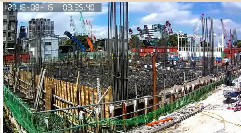
現場施作即時影像
