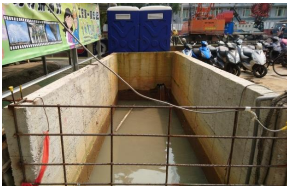
設置洗車台、沉澱池及沉砂池
