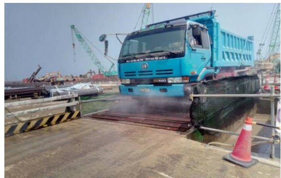
設置洗車台、沉澱池及沉砂池
