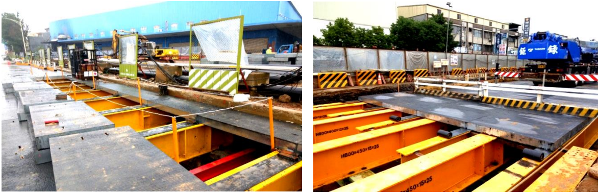
複合式覆蓋板、橡膠墊塊，降低行駛中音量
