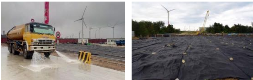
道路灑水清掃及防塵網覆蓋抑制揚塵
