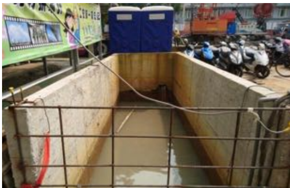
設置洗車台、沉澱池及沉砂池
