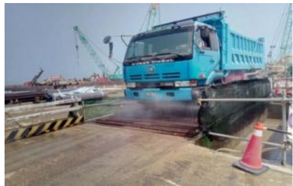
設置洗車台、沉澱池及沉砂池
